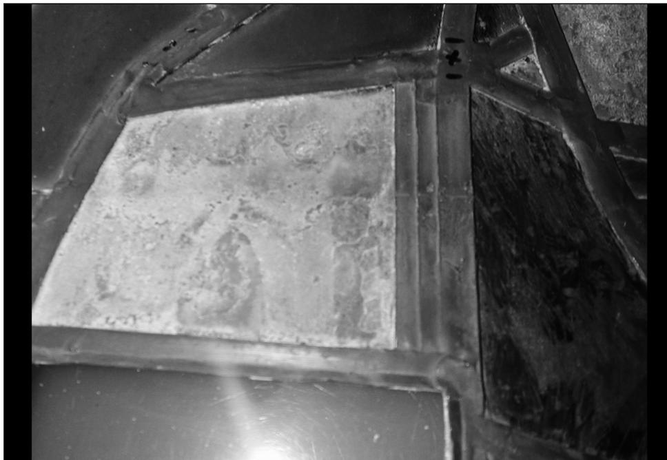
*Fig. 10. Detalle de red de emplomado en un panel donde se observa la utilización de plomos triples.
