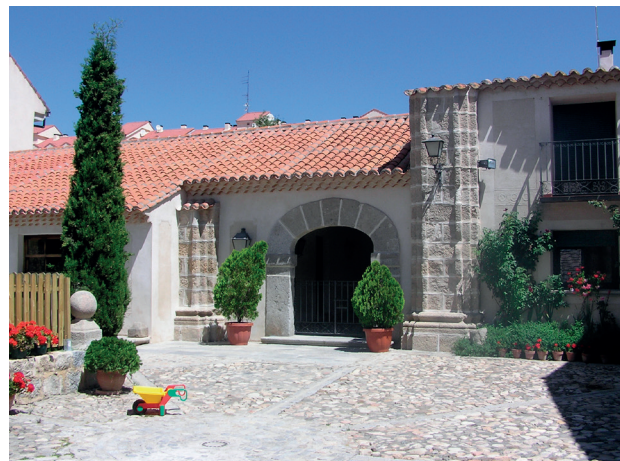
FIGURA 12.- PORTADA REAPROVECHADA Y PILASTRAS DEL MURO NORTE DE LA NAVE DEL TEMPLO. (Foto del autor).
