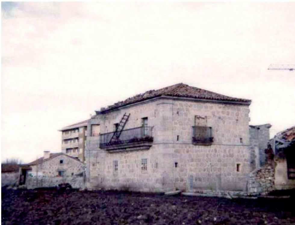
FIGURA 4.- VISTA DEL MONASTERIO DESDE EL SURESTE ANTERIOR A LA REFORMA DE 1990. CASA DEL ABAD. (AHPÁv).
