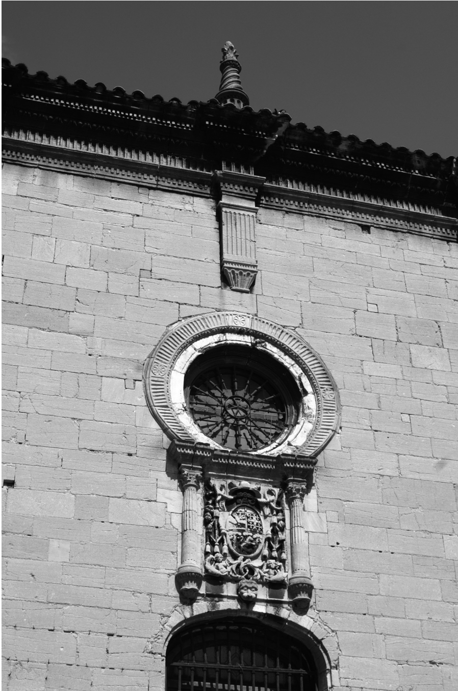
Detalle de la misma fachada, con el escudo del obispo García Pedrejón sobre el vano abierto con posterioridad. Obsérvese el rosetón, la disposición de la cornisa y el pináculo.
