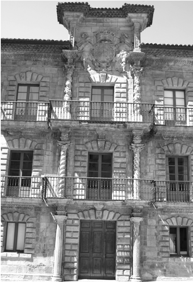
Calle central de la fachada del palacio de Camposagrado, construida a base de balcones muy desarrollados y superposición de órdenes, concediendo gran importancia al remate con escudo.
