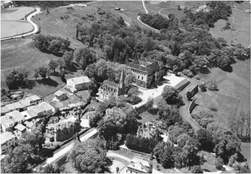
Vista del conjunto del Palacio de Sobrellano (1878-1889), la Capilla-Panteón (1878-1881) y El Capricho (1883-1885)
