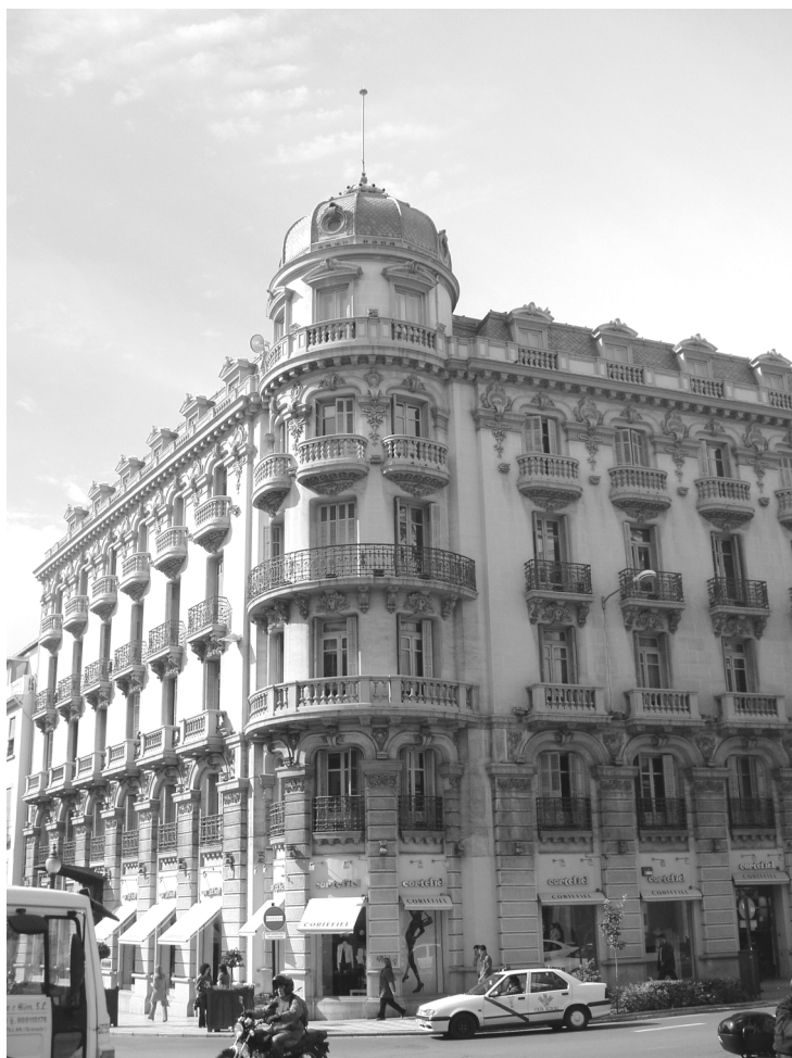
Fig. 11. Juan Monserrat y Vergés y Francisco Giménez-Arévalo. Hotel Colón (1902-1905). Gran Vía de Colón esquina Reyes Católicos, Granada.
