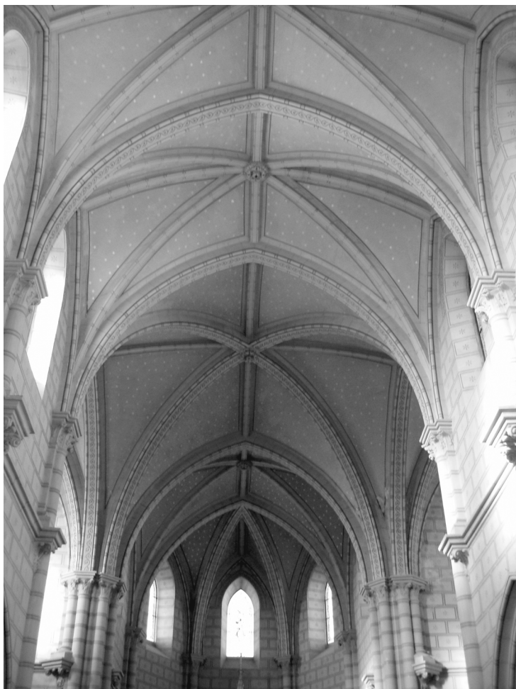
Fig. 7. Juan Monserrat y Vergés. Detalle de la bóveda estrellada. Iglesia Parroquial de Nuestra Señora de la Encarnación (1900). Gábia la Grande, Granada.
