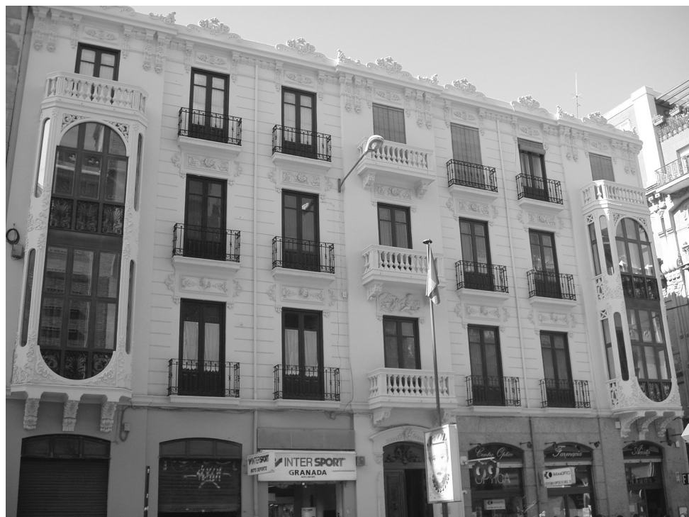
Fig. 10. Francisco Giménez-Arévalo. Residencia familiar y comercios (1906). Gran Vía de Colón núm. 27, Granada.
