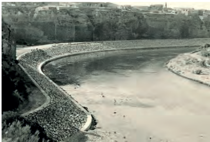
FIGURA 9. OBRAS DEL DESVÍO DEL CAUCE DEL GÁLLEGO BAJO SAN MATEO DE GÁLLEGO. AÑO 1985. Foto: Archivo familiar J. Mondourrey.
