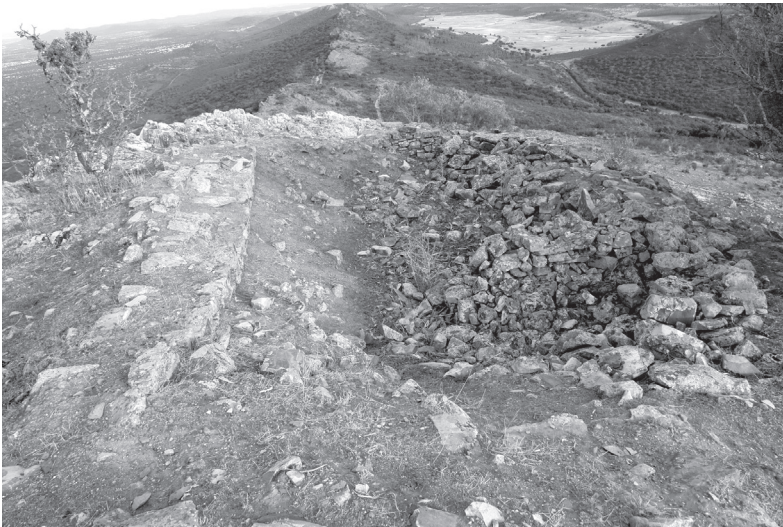
Fig. 2 Restos de cimentación del probable edificio religioso del Torrico de San Pedro (Salorino, Cáceres) Foto: Víctor Gibello Bravo.
