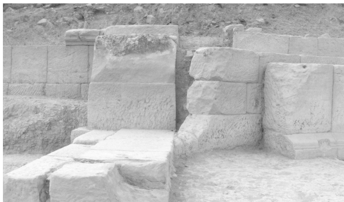
Fig. 4: El muro de cierre por el Sur
