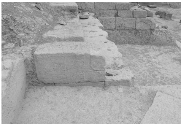
Fig. 3: Detalle de la unión de los muros O(1) y N
