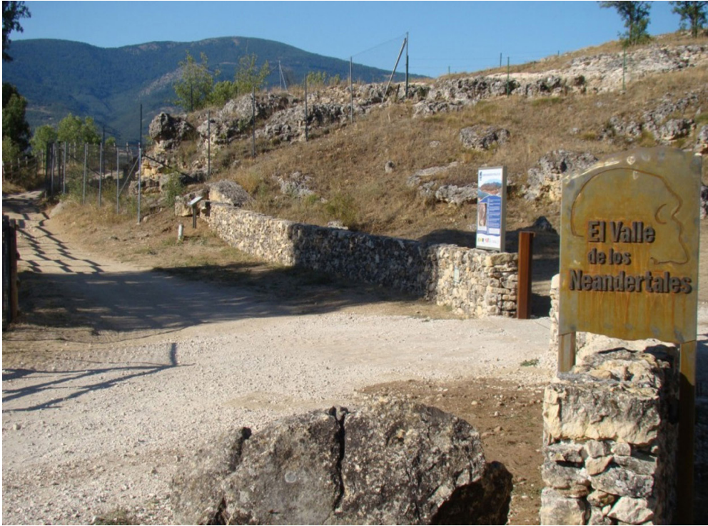
FIGURA 16- CONSTRUCCIÓN DE MURO DE CIERRE CON CALIZA DE LA ZONA. SEÑALIZACIÓN DE LA ENTRADA.
