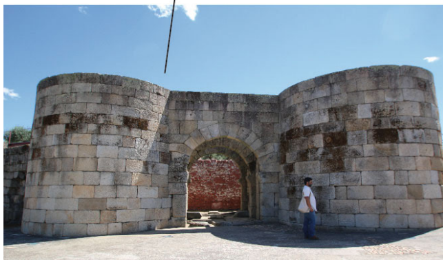
FIG. 3. PUERTA PRINCIPAL DE LA MURALLA DE LA CIUITAS IGAEDITANORUM / EGITANIA; FOTOGRAFÍA AÉREA CON EL TRAZADO DE LA MURALLA Y PORTILLO QUE PERMITE LA ENTRADA AL CONJUNTO EPISCOPAL.
