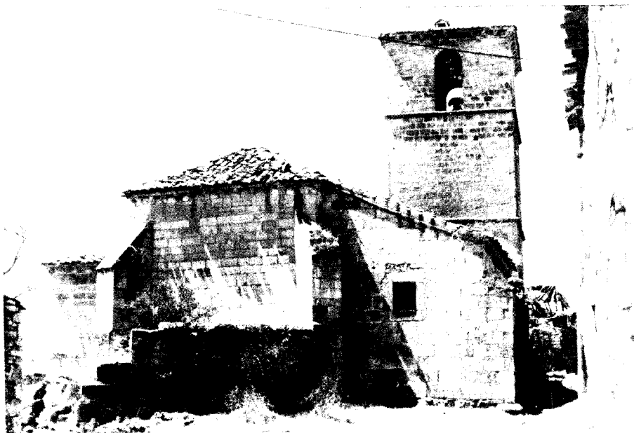
Fig. 8: Vista exterior del abside.
