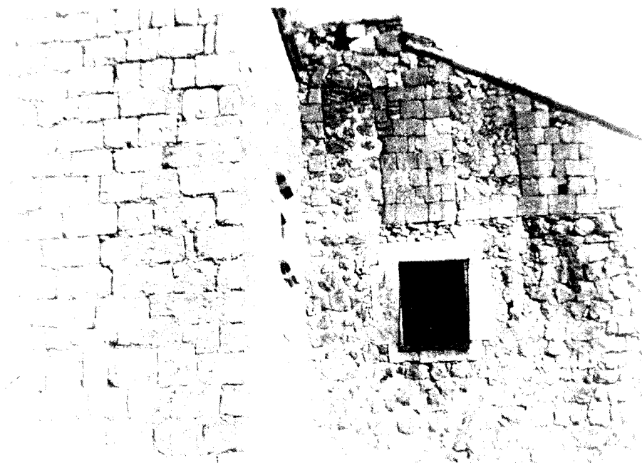
Fig. 13: Parte de la fachada occidental en la que sobresale el cuerpo de la torre y en la que se observan dos vanos con arcos de medio punto actualmente cegados.
