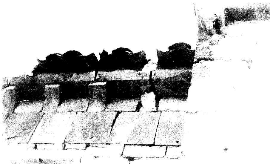
Fig. 12: Detalle de las mensulas de la fachada sur.
