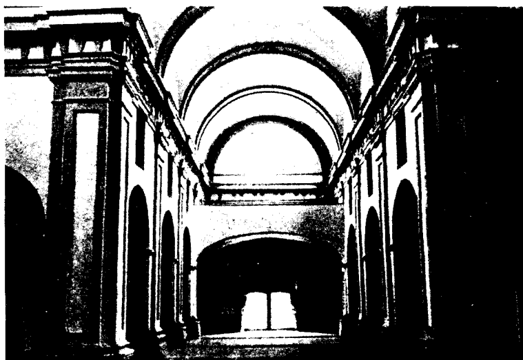
Fig. 10. Aspecto del cuerpo de la Iglesia Nueva.
