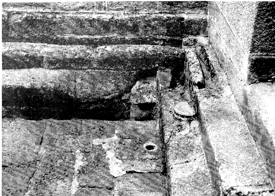
Lám. 10. Pormenor do esgoto e do cano-ladrão no canto SW de P2.
