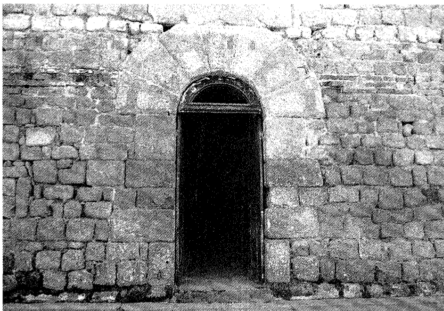
Lám. 13. Porta romana da 2.ª fase, existente na fachada Norte do edifício.
