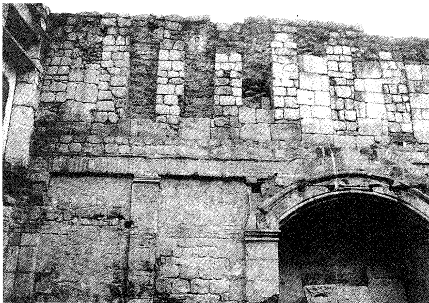
Lâm. 12. Aspecto da parede Oeste da sala de P2.
