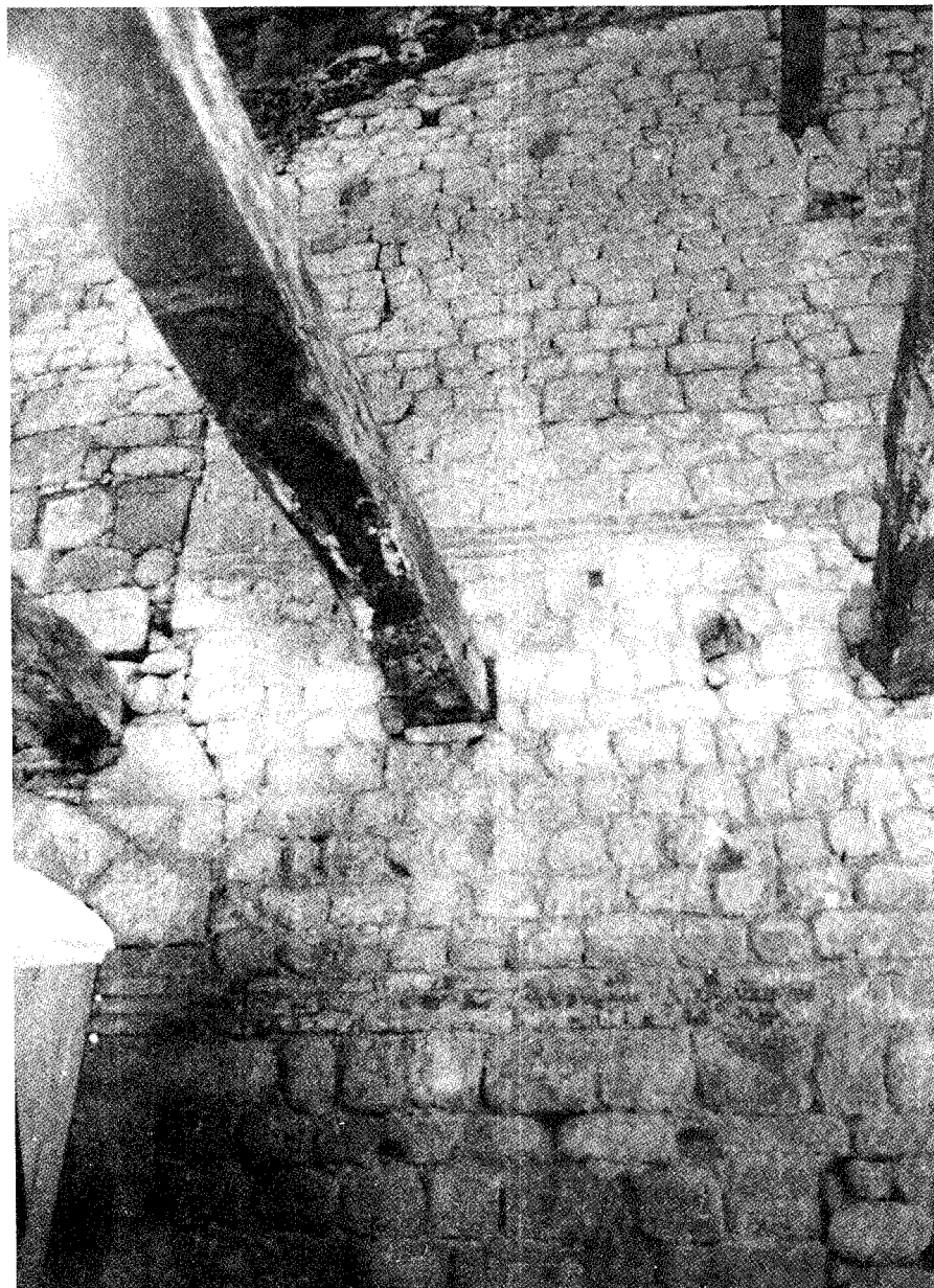
Lâm. 11. Pormenor da curvatura da abóbada romana.
