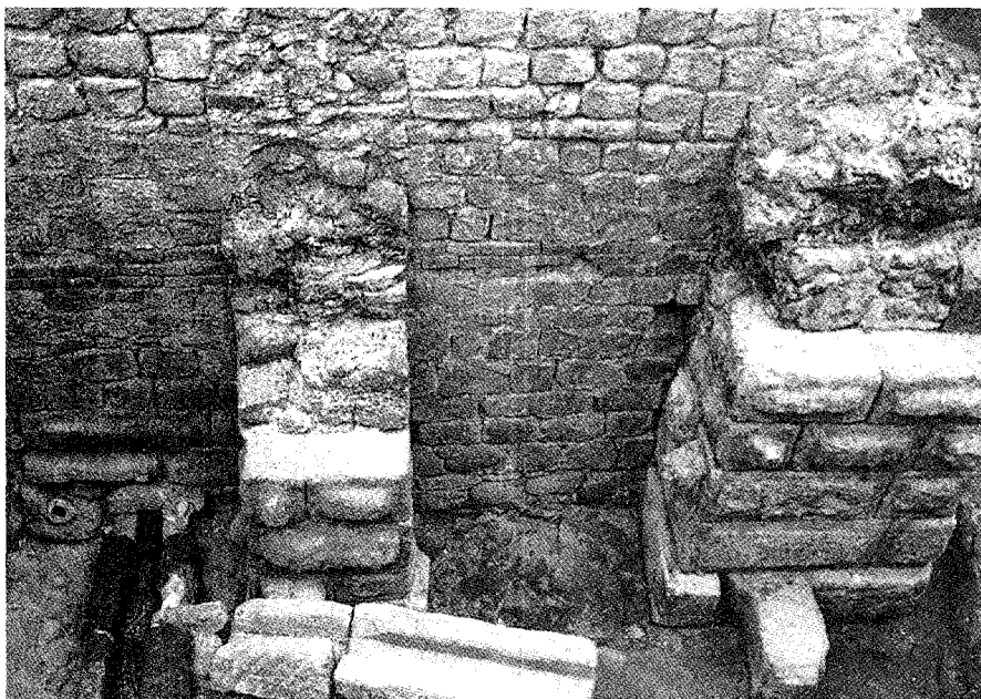
Lâm. 2. Contrafortes com pedras almofadadas na face externa da parede Sul.
