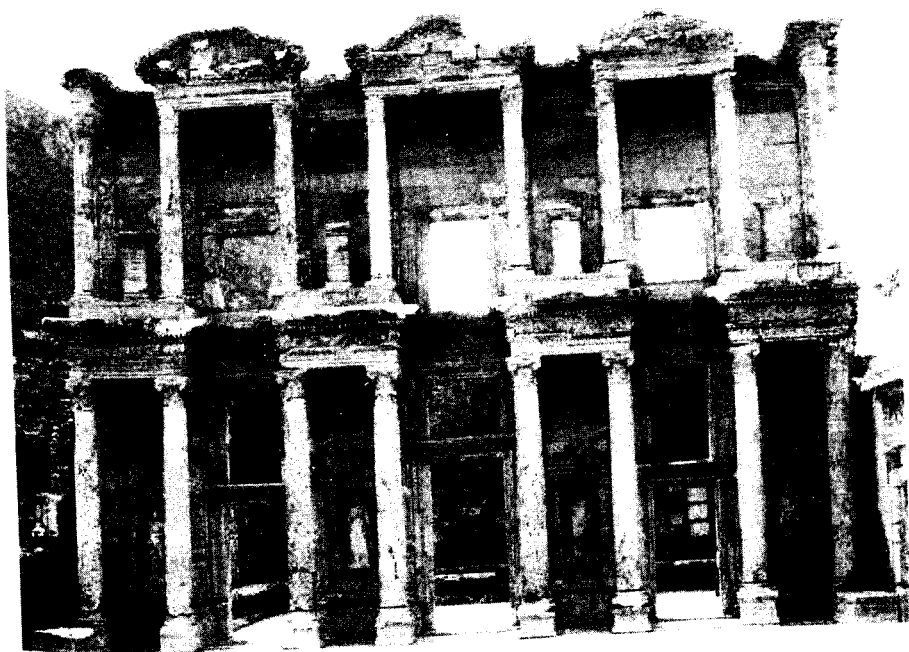
Fig. 4. Biblioteca de Éfeso, fachada.
