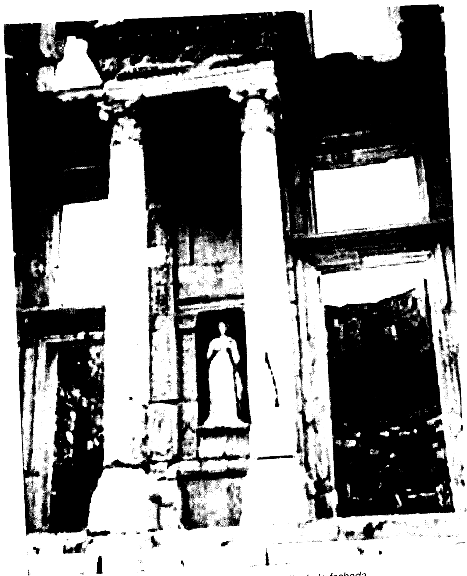
Fig. 5. Biblioteca de Éfeso, detalle de la fachada.
