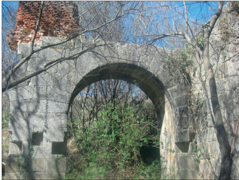
FIGURA 9. PRIMER ARCO COMPLETO, ARRANQUE DEL 2º ARCO Y MURO DE LADRILLO EN LA PLANTA SUPERIOR DE LA FACHADA PRINCIPAL DEL MOLINO DE MÁRMOL. Fuente: F. V. Sánchez Martínez
