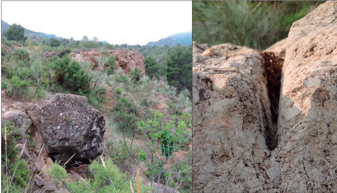
FIGURA 9. IZQUIERDA: TRABAJOS EN LA CANTERA DE LA RULA (TÍJOLA, ALMERÍA). DERECHA: DETALLE DE LA MARCA DE UN CUÑERO, CON EL QUE SE PROCEDE AL CORTE DE LA PIEDRA (CANTERA DE LA RULA, TÍJOLA, ALMERÍA). Fotos: A. Molina Franco
