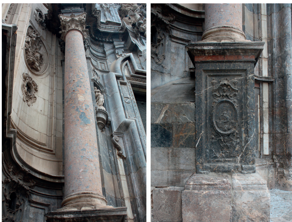
FIGURA 9. FACHADA DE LA CATEDRAL DE MURCIA. DETALLE DE LAS DISTINTAS VARIEDADES DE ROCA ORNAMENTAL EMPLEADAS EN LA ARTICULACIÓN ARQUITECTÓNICA DE LA PUERTA PRINCIPAL O DEL PERDÓN. Fuente: J.A. Antolinos y B. Soler
