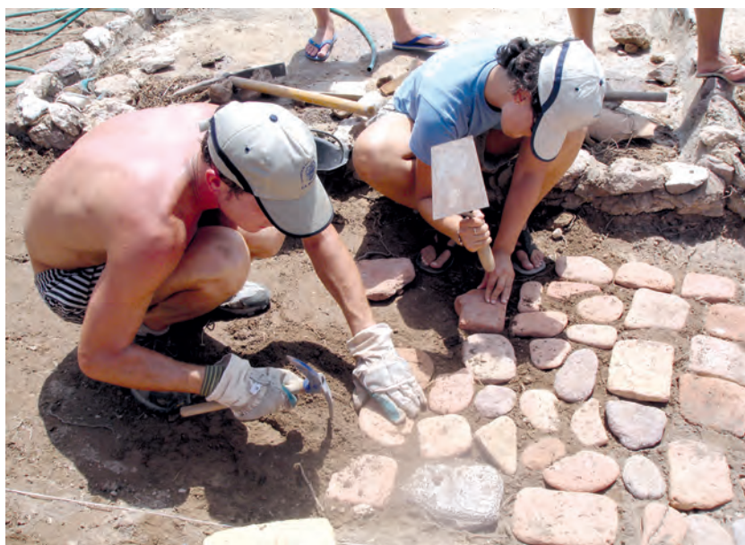
Reconstrucción de calzadas en los alrededores de la Estación Biológica por grupos de voluntarios.
