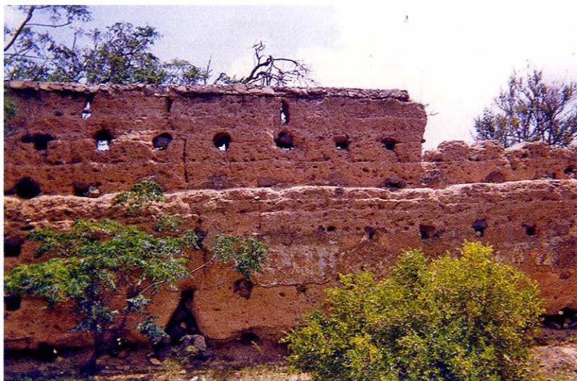
Fig. 26. Parte interna del lienzo este, con las aspilleras y la banqueta. Fotografía Lucas Pedro Calderón Ruiz, septiembre de 1984.
