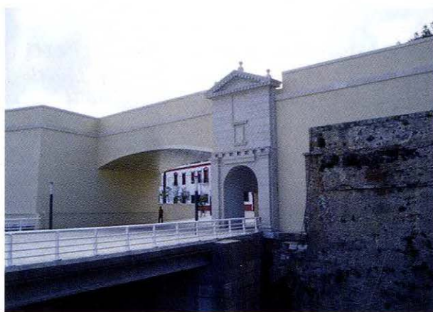
Reconstrucción de la puerta del Puente del Cristo. Foto del Autor.
