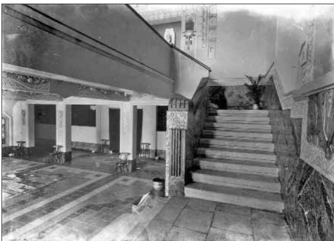
Fig. 8. Detalle de una de las escaleras, 1932 (ACM).
