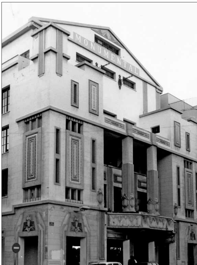
Fig. 29. Fachada principal en su estado actual.
