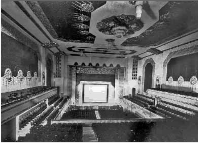
Fig 11. Vista de la sala interior y palcos, 1932 (ACM).
