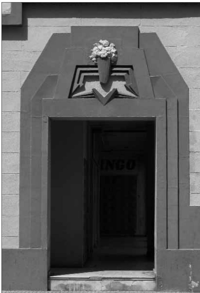
Fig. 32. Puerta con detalle ornamental, estado actual.
