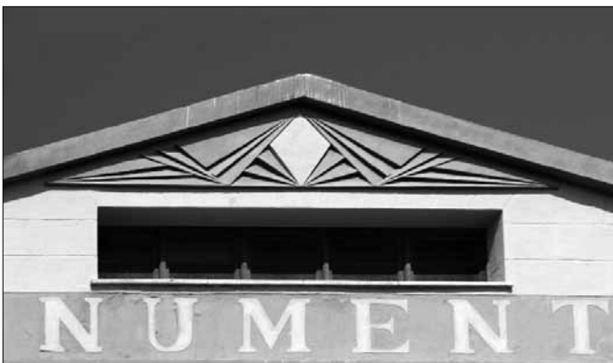
Fig. 31. Remate del frontón de fachada, estado actual.
