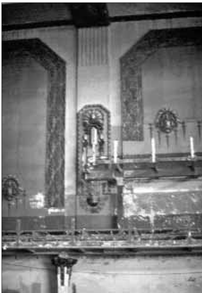
Fig. 25. Vista de elementos decorativos, durante su destrucción, 1981 (JMSC).
