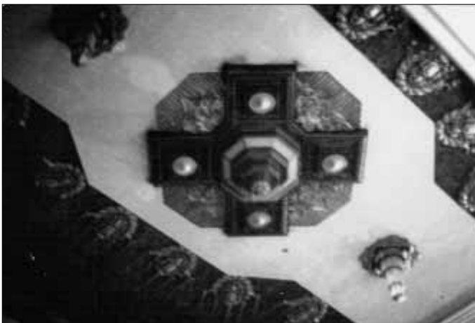
Fig 23. Detalle de lámparas en el interior del cine, durante su destrucción, 1981 (fotografía de Jesús Miguel Sáez Cazorla, desde ahora JMSC).
