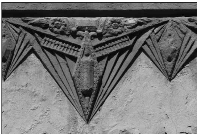
Fig. 33. Detalles ornamentales de fachada, estado actual.
