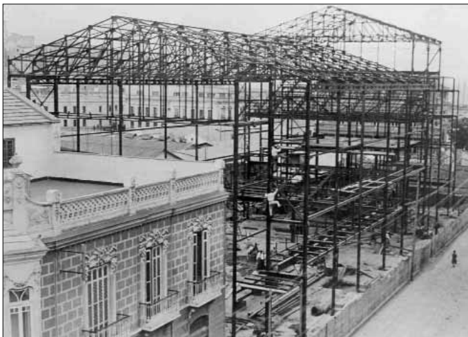
Fig 2. Estructura metálica del edificio durante su construcción, 1930-1931 (ACM).
