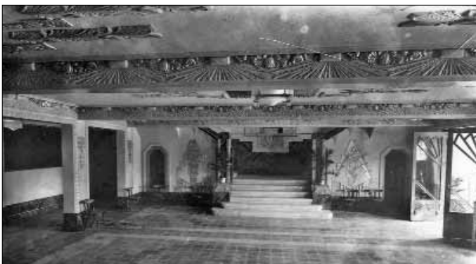
Fig 7. Vista frontal de una de las escaleras de acceso a la planta principal, 1932 (ACM).
