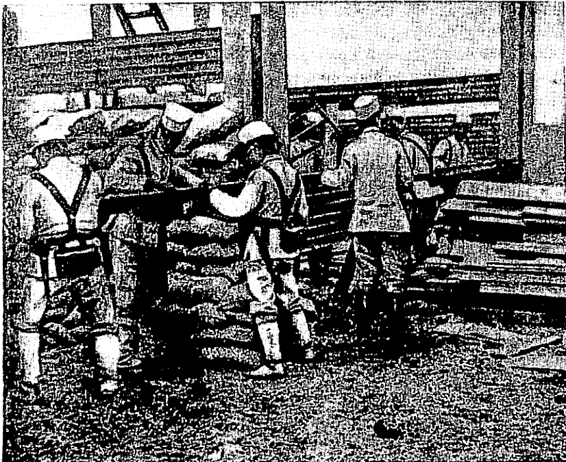
Construcción del blocao número 2
