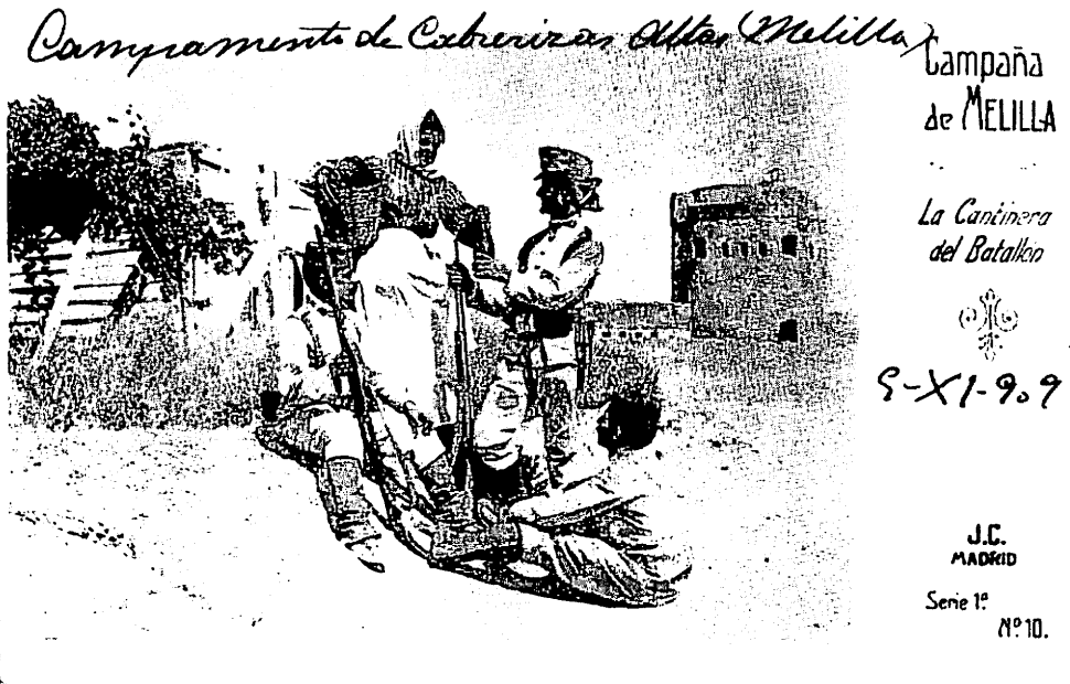
Soldados y cantinera junto a la torre de Santa Bárbara, actual Plaza de España
