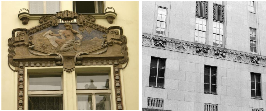
Imagen 3: A la izquierda, detalle de la decoración en una central de Praga (República Checa) de principio de siglo 10 . A la derecha, central telefónica de Elm Street , Cincinnati (Estados Unidos), 1930, Harry Hake 11 .
